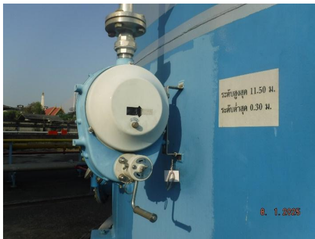
รูปที่ 2.2.1-2 Level Gauge
