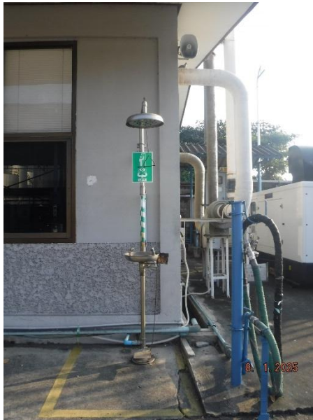
รูปที่ 2.2.4-3 ที่ล้างตาและอาบน้ำฉุกเฉิน
