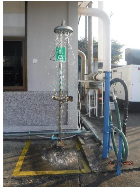
รูปที่ 2.2.4-3 ที่ล้างตาและอาบน้ำฉุกเฉิน
