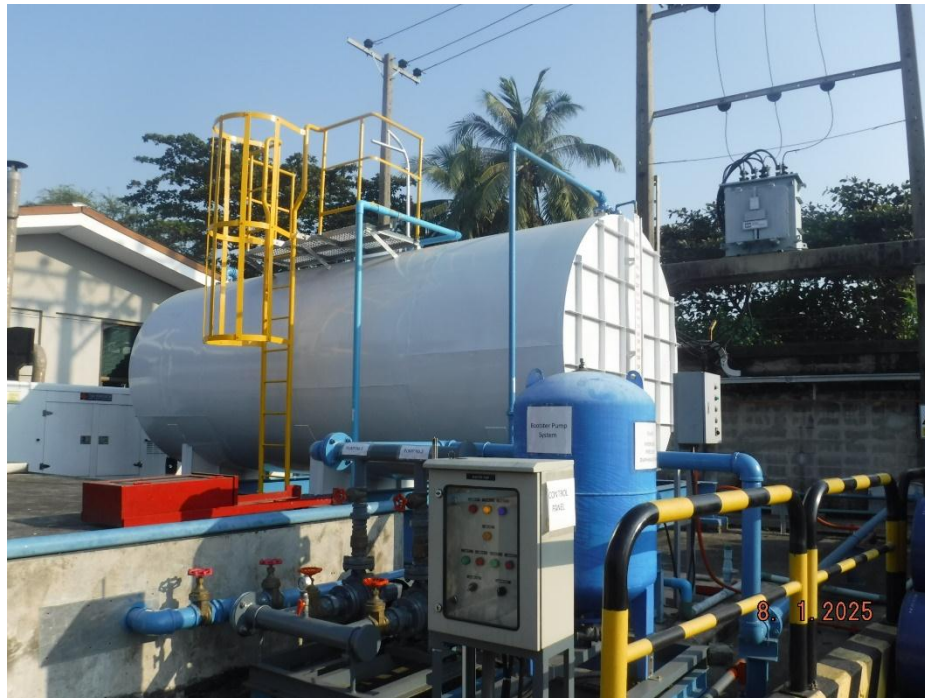
รูปที่ 1.7-3 ติดตั้งเครื่อง Booster Pump และ แท็งก์น้ำ แทนของเดิม
