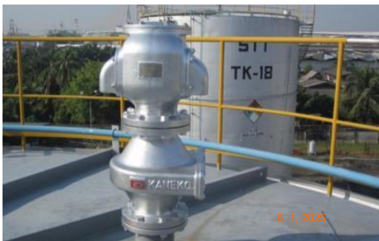
รูปที่ 2.2.1-1 Automatic Breather Valve
