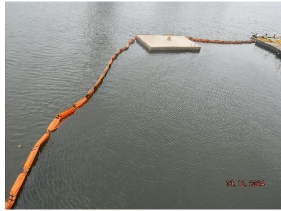
รูปที่ 2.2.2-8 การวาง Boom ทางทิศเหนือ (ซ้าย) และทิศใต้ (ขวา)
