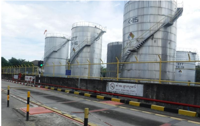
รูปที่ 2.2.1-8 กำแพงคอนกรีตเสริมเหล็กที่ล้อมรอบถังเก็บเคมีภัณฑ์
