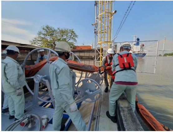
รูปที่ 2.2.2-8 การวาง Boom ทางทิศเหนือ (ซ้าย) และทิศใต้ (ขวา)
